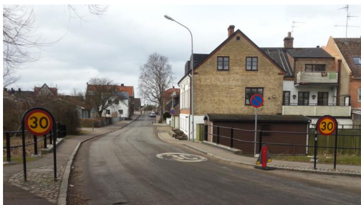
Figur 7 Smal sektion vid bro över Lussebäcken. Gångbanorna på vardera sida är idag 1,1 meter breda.
